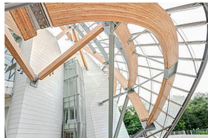
222 einfach und zweifach gekrümmte BSH-Binder
